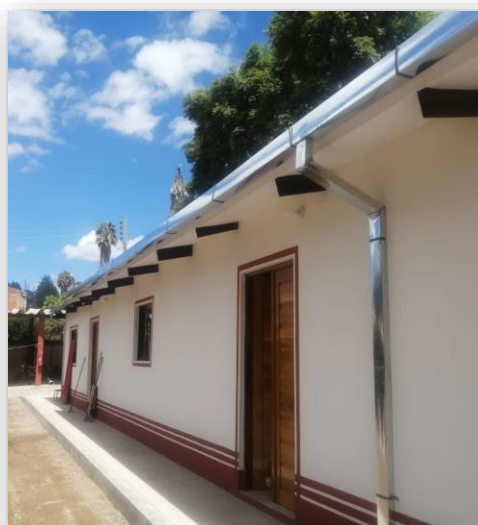
Mejoramiento de la vivienda de portería
