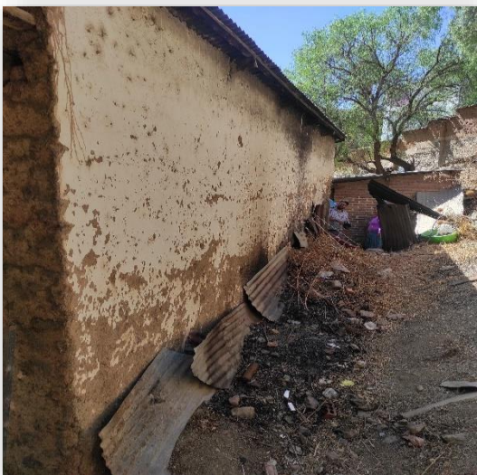
Demolición de ambientes muy deteriorados y abandonados
