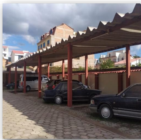
Mejoramiento del muro perimetral y columnas del garaje
