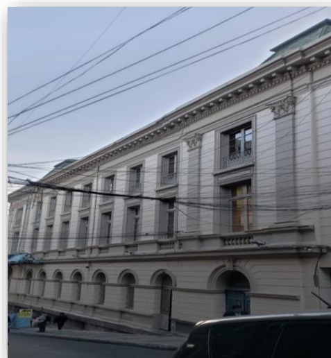
Mantenimiento de fachadas laterales
