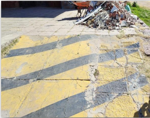
Rampa de acceso a la imprenta completamente deteriorado
