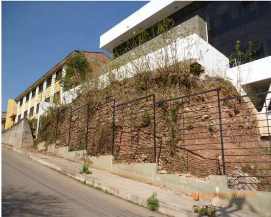
Talud en socavación provocando riesgo en el voladizo de la infraestructura
