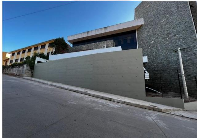
Talud en socavación provocando riesgo en el voladizo de la infraestructura
