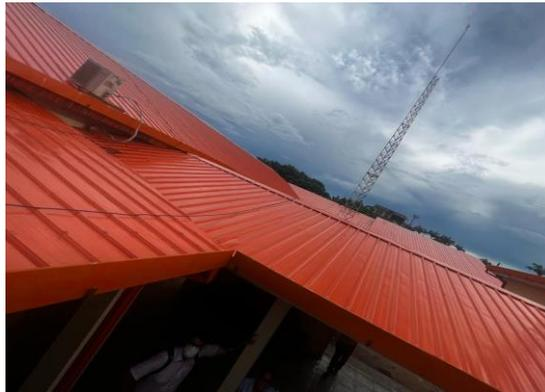
**Se realizó mantenimiento de toda la cubierta, canaletas y bajantes**
