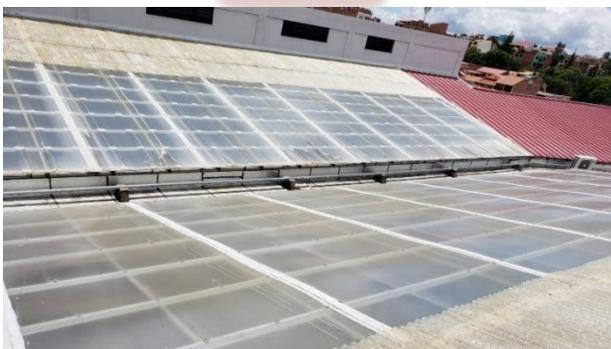
Cubierta de policarbonato deteriorada por el desgaste del sol y lluvia.
