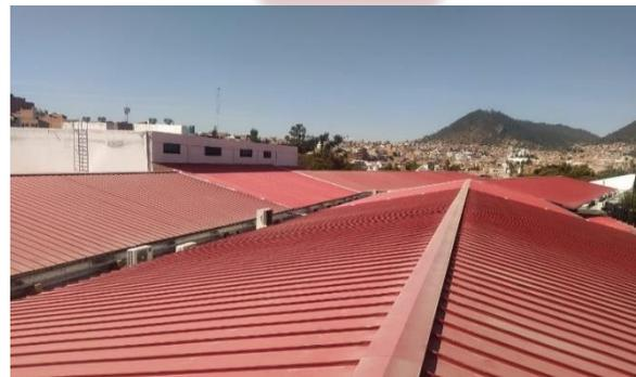
Se realizó el cambio de policarbonato a cubierta de calamina para mayor durabilidad en el tiempo.
